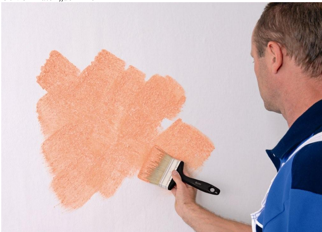
Obr. 8 – nátěr „do kříže“
