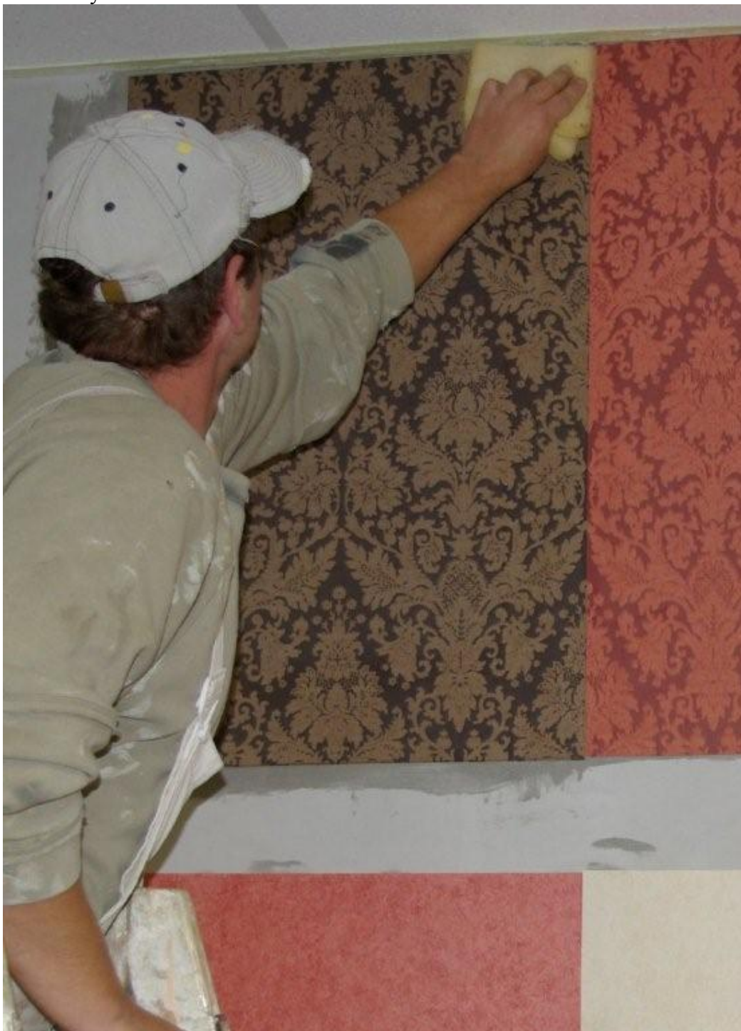
Obr. 5. Vyhlazení houbičkou
