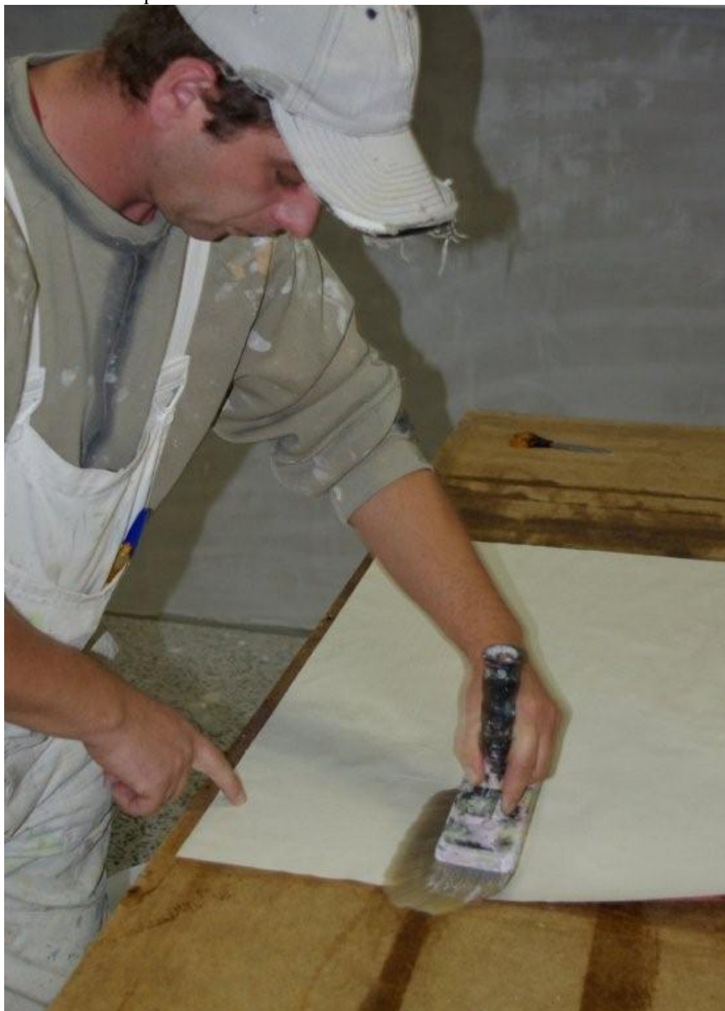
Obr. 2. Nátěr lepidla
