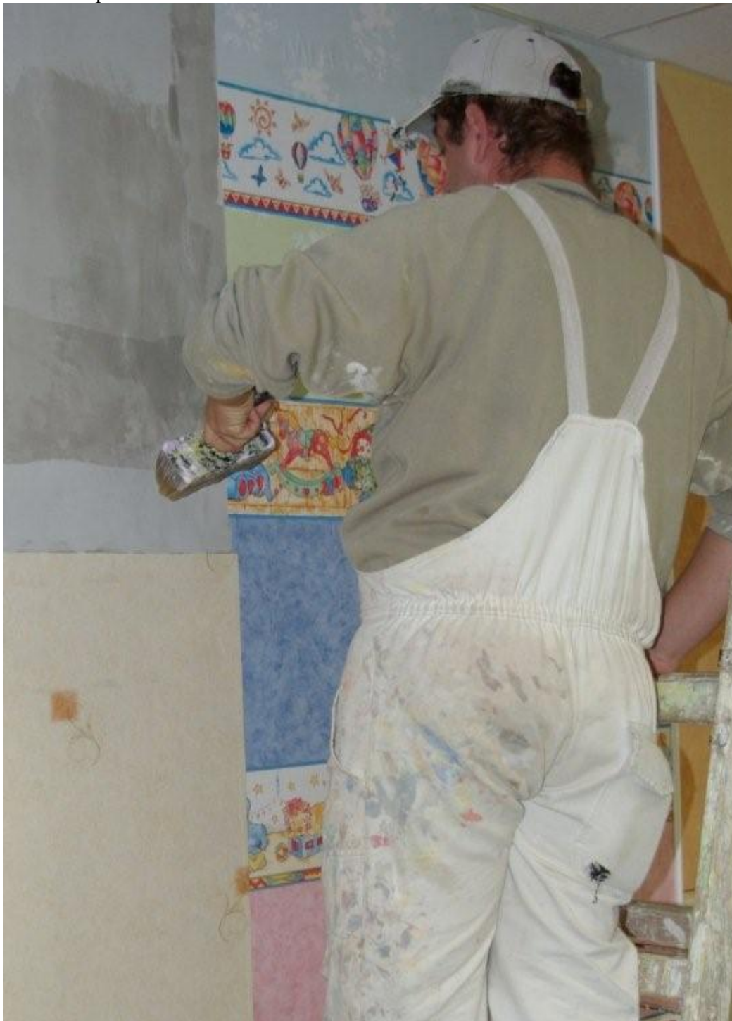
Obr. 4. Lepidlo na zeď
